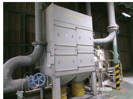
ภาพที่ 2.2-6 ระบบบำบัดแบบถุงกรอง (ระบบสำรอง)
