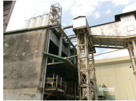
ภาพที่ 2.2-2 ปล่อง Electrostatic Precipitation
