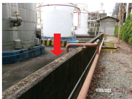
ภาพที่ 2.2-36 Dike กันรอบถังเก็บสารเคมี
