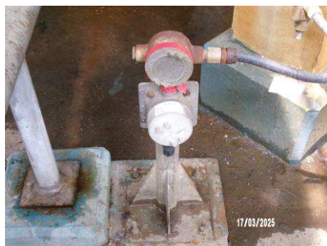
ภาพที่ 2.2-34 Gas Detector
