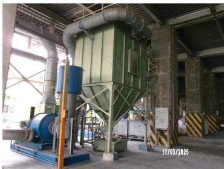
ภาพที่ 2.2-5 ระบบบำบัดแบบถุงกรอง (ระบบหลัก)
