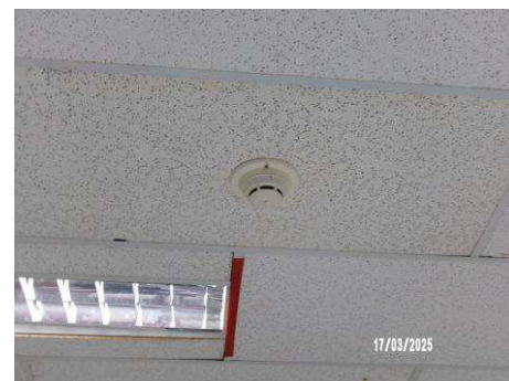
ภาพที่ 2.2-35 Smoke and Heat Detector
